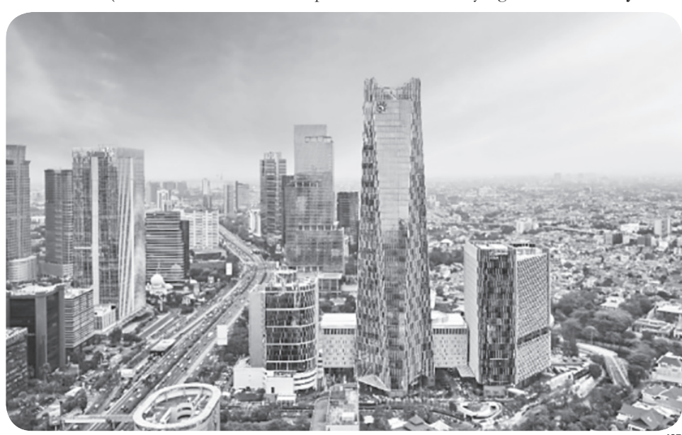
Gedung PT Telkom Indonesia (Persero) Tbk (Telkom).
